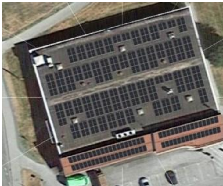
Montasje av solceller pågå når. (Foto: Coop - prospekt)
